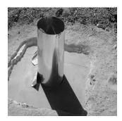
2 En caso de longitudes de tubo largas atornillar los tubos y acoplamos los bordes hasta que haga "Clic". A continuación sellamos con la cinta de aluminio autoadhesiva por la parte exterior del tubo (la cinta se coloca desde 20 mm por debajo de la zona no rizada del tubo hasta el tope inferior del mismo). Recomendamos utilizar una pistola de aire caliente para una mayor fijación de la cinta.
