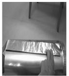
3 Después de asegurar la base del tejado con tornillos ( aplicar silicona bajo los tornillos ) impermeabilizando bien la zona donde se emplaza la base de tejado, insertamos el tubo de la longitud elegida en el collar y acoplamos este en la base de tejado fijándolo a la misma con los tornillos correspondientes. El tubo debe sobresalir 1cm. por encima del collar.
