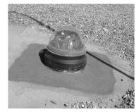
**5** Ajustamos el domo sobre la base de tejado, de tal manera que las guías de tornillos del domo estén sobre la parte estrecha de la base de tejado. Aseguramos el domo a la base de tejado con tornillos. Después completaremos la operación atornillando hasta el interior del tubo.
