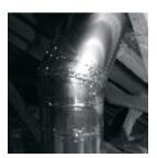
7 Unimos el tubo inferior que es aquel que no tiene parte rizada, con el codo para completar el conjunto. Si la parte inferior del tubo coincide con la abertura realizada en el techo, procederemos a sellar las juntas que unen el codo a los dos tubos con la cinta de aluminio autoadhesiva. Retiramos el embellecedor del plafón difusor. Realizamos las marcas para los tornillos con las guías del plafón difusor y taladramos los agujeros sobre el techo.
